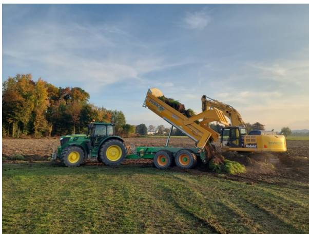
Die zweite Bauetappe der Bodenverbesserung wird im Jahr 2023 eingeplant.
