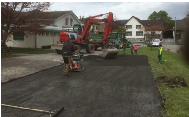
Parkplatzneubau Alter Kindergarten
